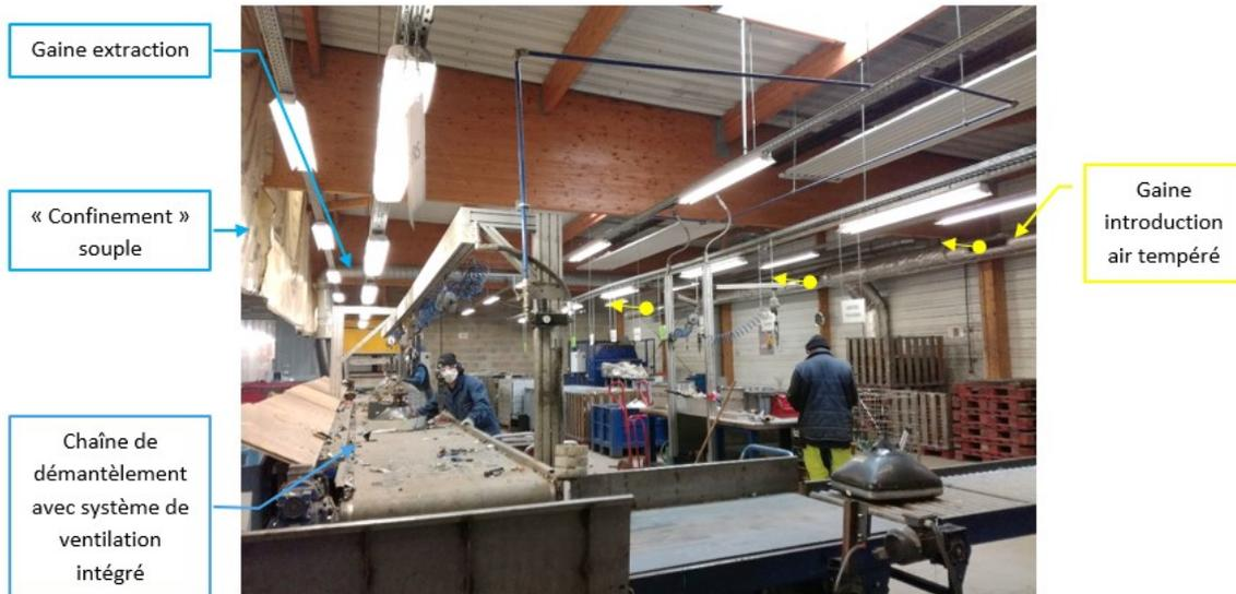
FIGURE 33 : LES DIFFERENTS ELEMENTS DU SYSTEME DE VENTILATION DANS L'ATELIER
